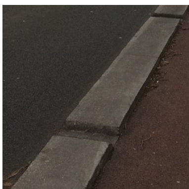
Figuur 2 - verhoogde wegmarkering van beton
